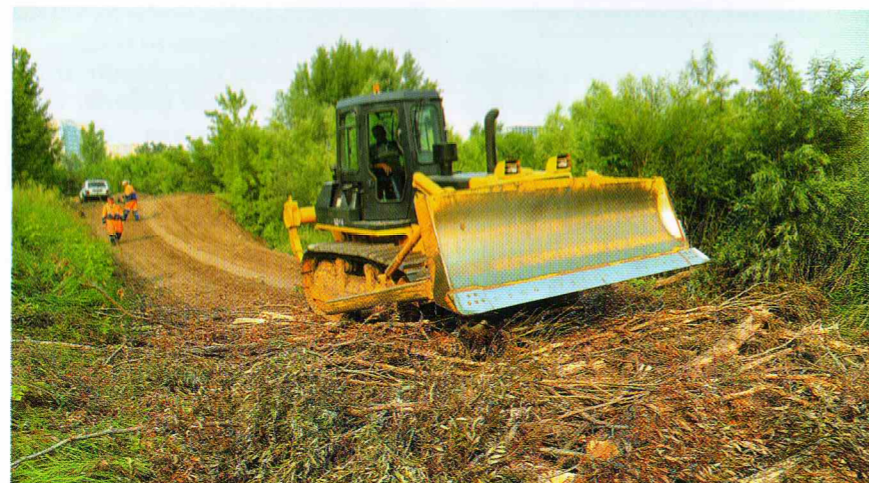
Расчистка полосы отвода будущей дороги
