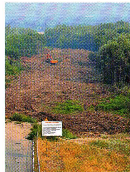
Расчистка полосы отвода 1-го участка
