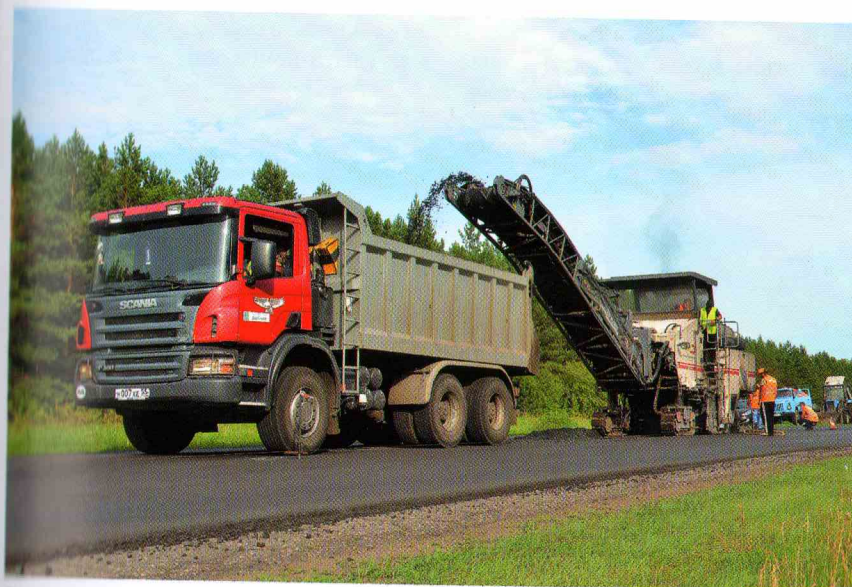
Ремонт дороги Омск-Тара
